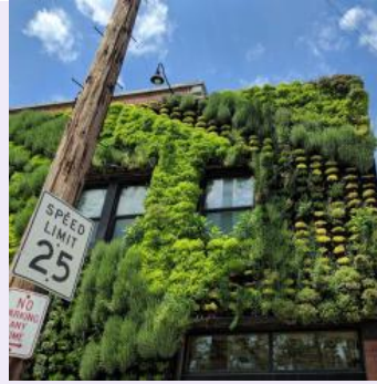
Foto da Parede Viva Florafelt Pockets em Cleveland, Ohio, pela arquiteta Marika Shiori-Clark para o Distrito Regional de Esgotos do Nordeste de Ohio. ( https://www.plantsonwalls.com/blog/living-walls-absorb-noise-outperform-most-materials/ )
